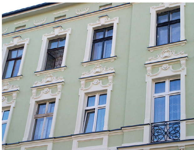
Sl. 13. Rekonstrukcija povijesne fasade polistiremskim profilima.
