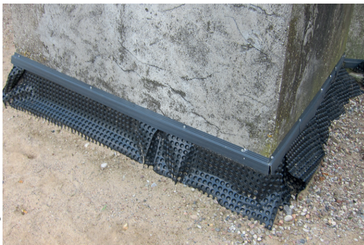
Sl. 8. Kruta folija omotana oko temelja crkve sagrađene od velikih nepravilnih gromada. Folija će zaustaviti isparavanje vode, a ako su fuge ispunjene mortom, stvaraju se uvjeti za kapilarno prodiranje ograničeno isparavanjem i strukturnu vlagu. Foto: Bogumiła Rouba (2012).
